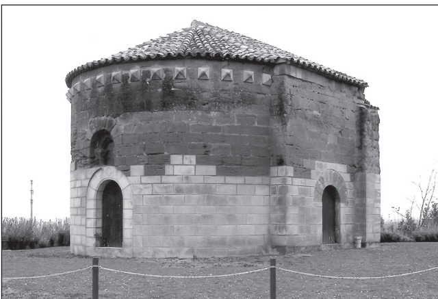
FIGURA 3: Vista de la cara norte y ábside original del edificio religioso
