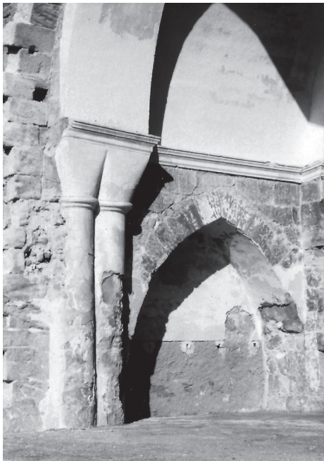
FIGURA 4: Columnas pareadas con capiteles lisos, en el transcurso de la reconstrucción de 1985
